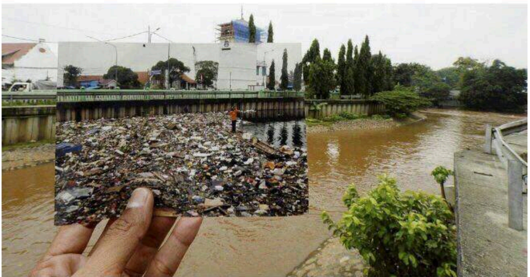
Potret sampah yang memenuhi Kali Besar pada Januari 2013 dan kondisi Kali Besar awal September 2016.
